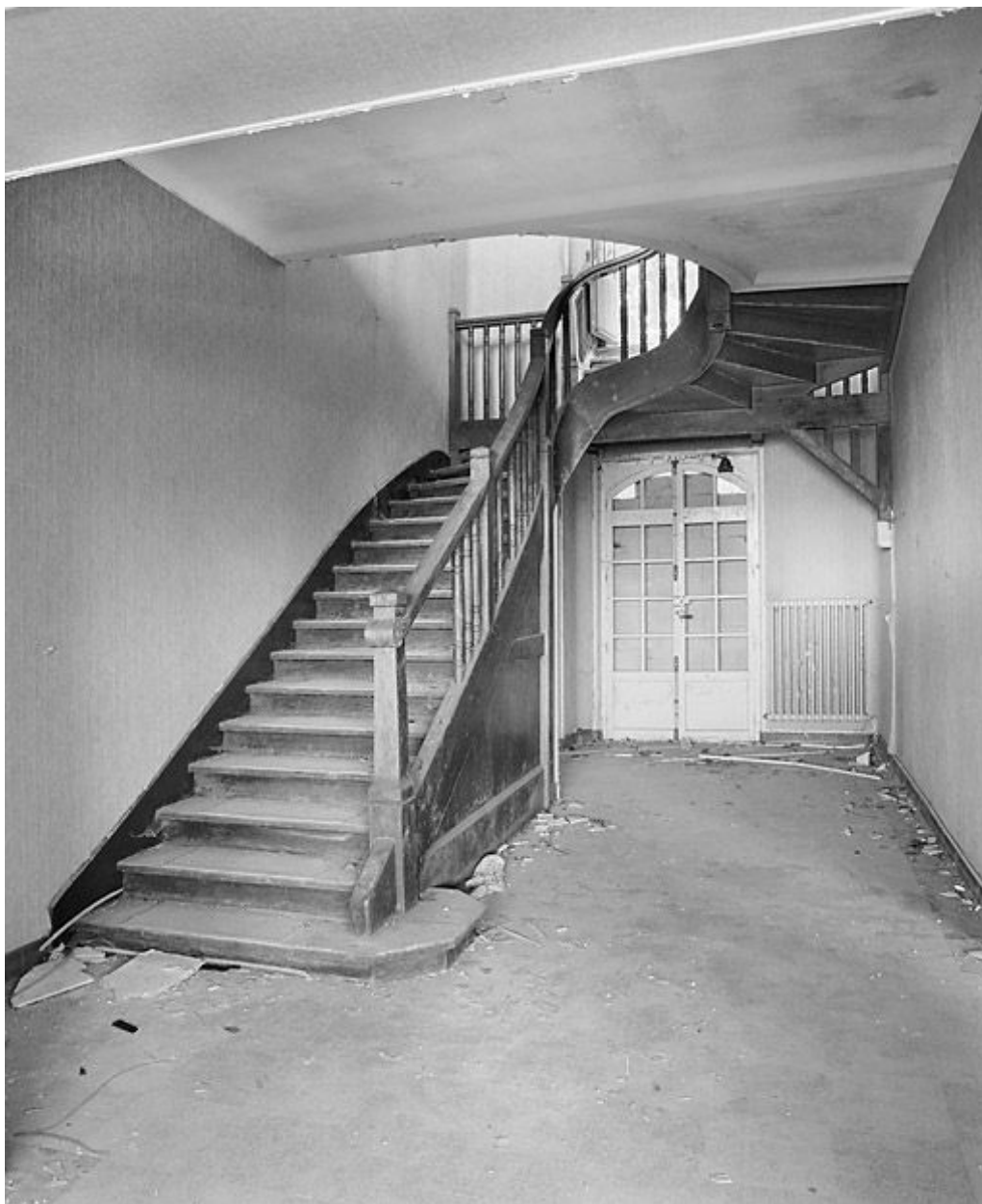
Pavillon est du bâtiment central : escalier.
