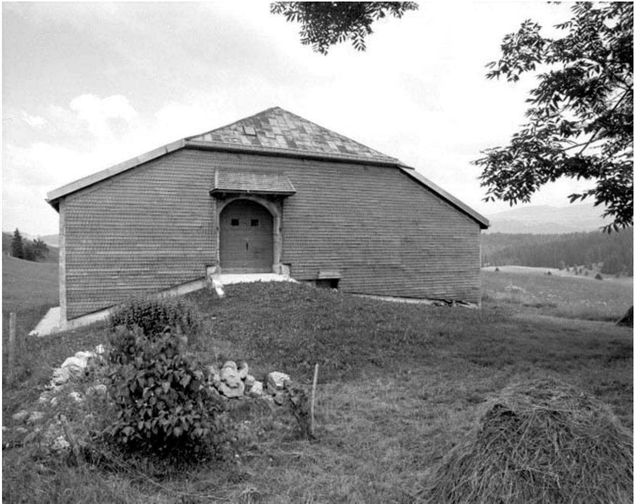
Bellecombe, ferme : pignon avec essentage de tavaillons et grange haute.
