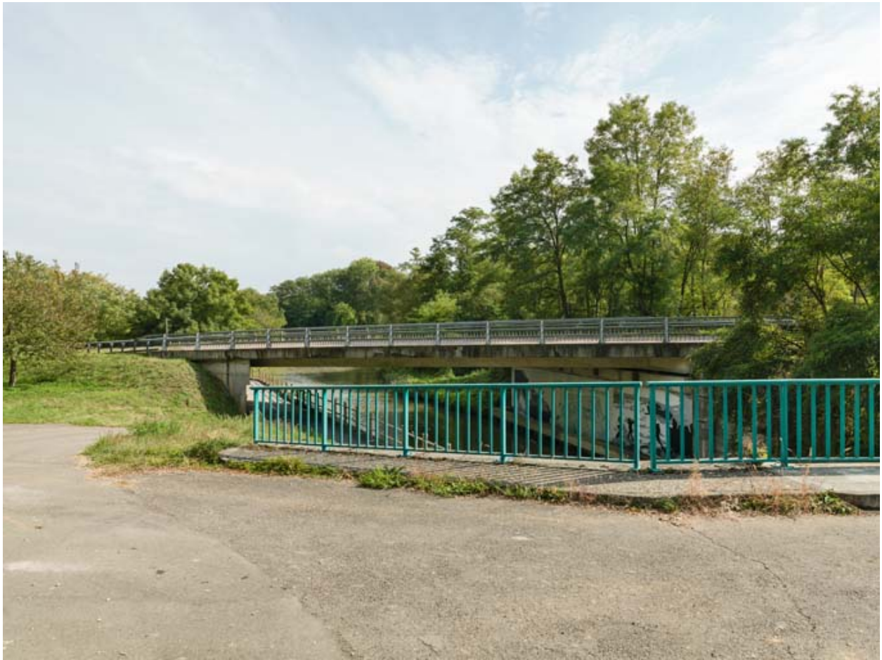
Vue d'ensemble du pont.
