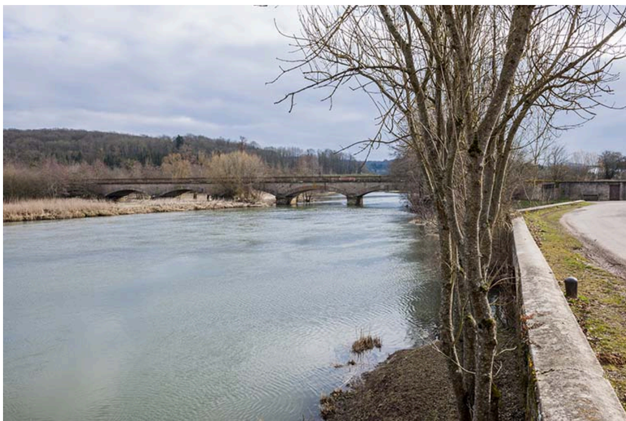
Pont ferroviaire sur la Lanterne (ligne Nancy-Gray).
