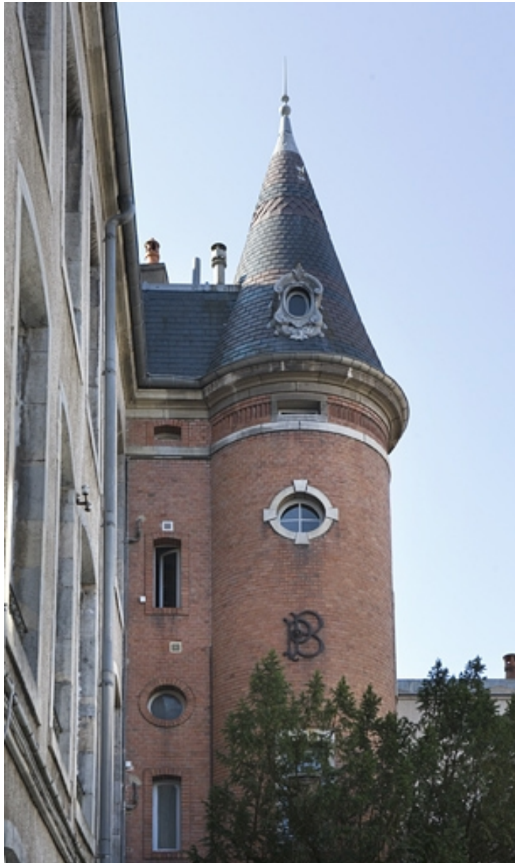
Détail de la partie supérieure de la tour d'escalier, de profil.
