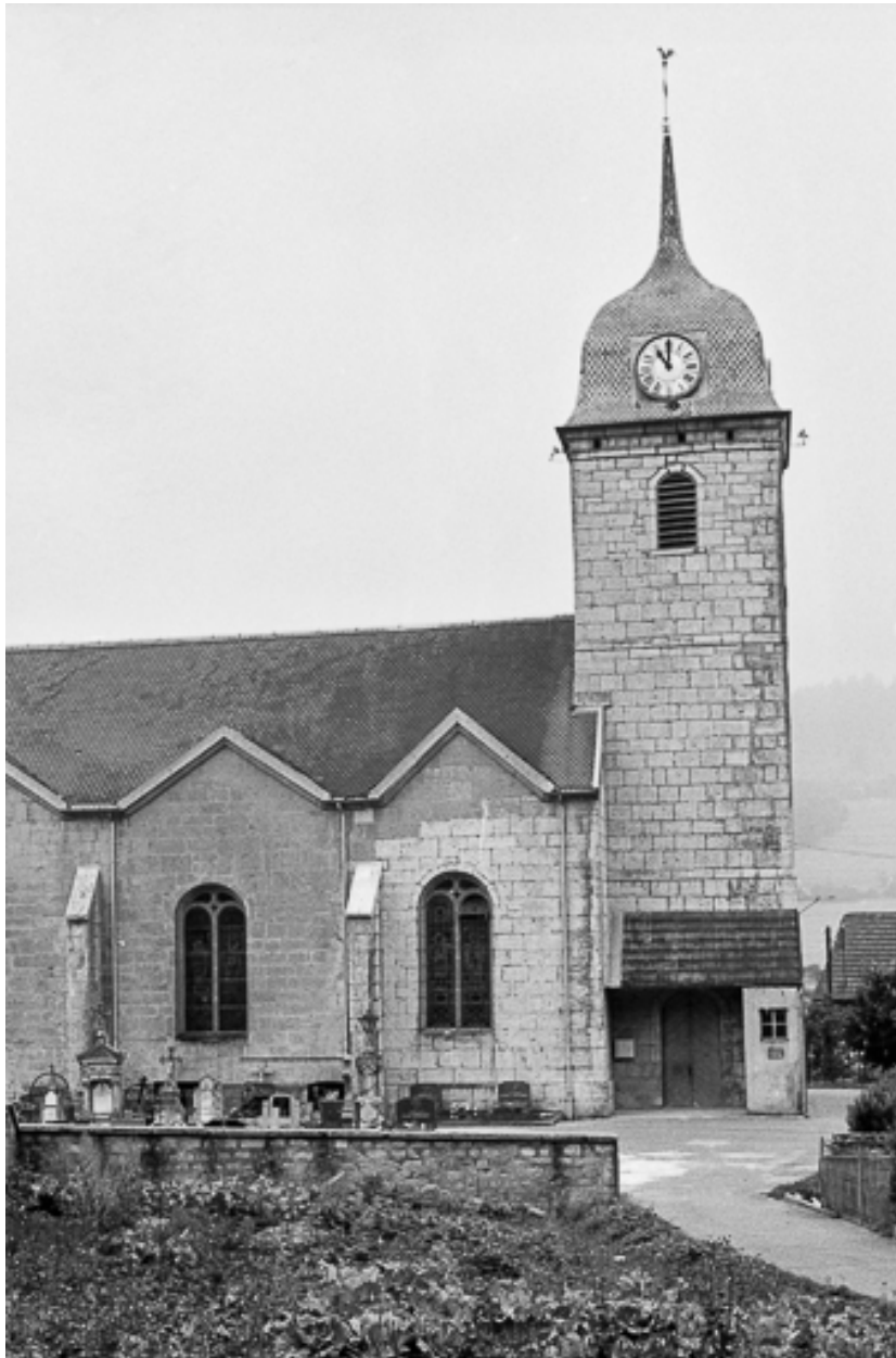
Façade latérale gauche et clocher.
