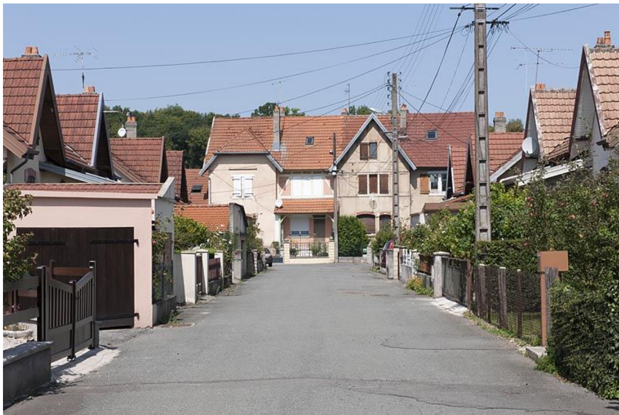
Impasse des Mimosas. Vue d'ensemble.
