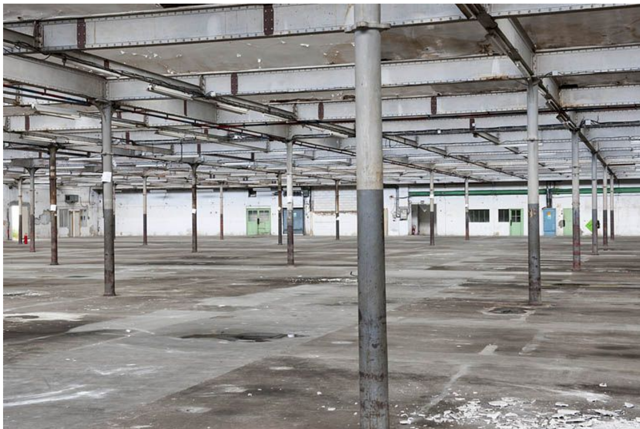
Salle de filature. Vue depuis le nord-ouest.
