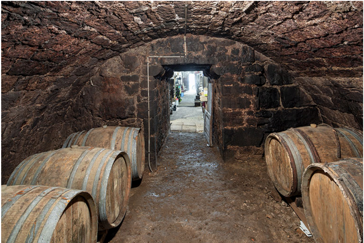
Cave du bâtiment sur rue. Pièce maçonnée à l'extrémité ouest de la travée centrale.
