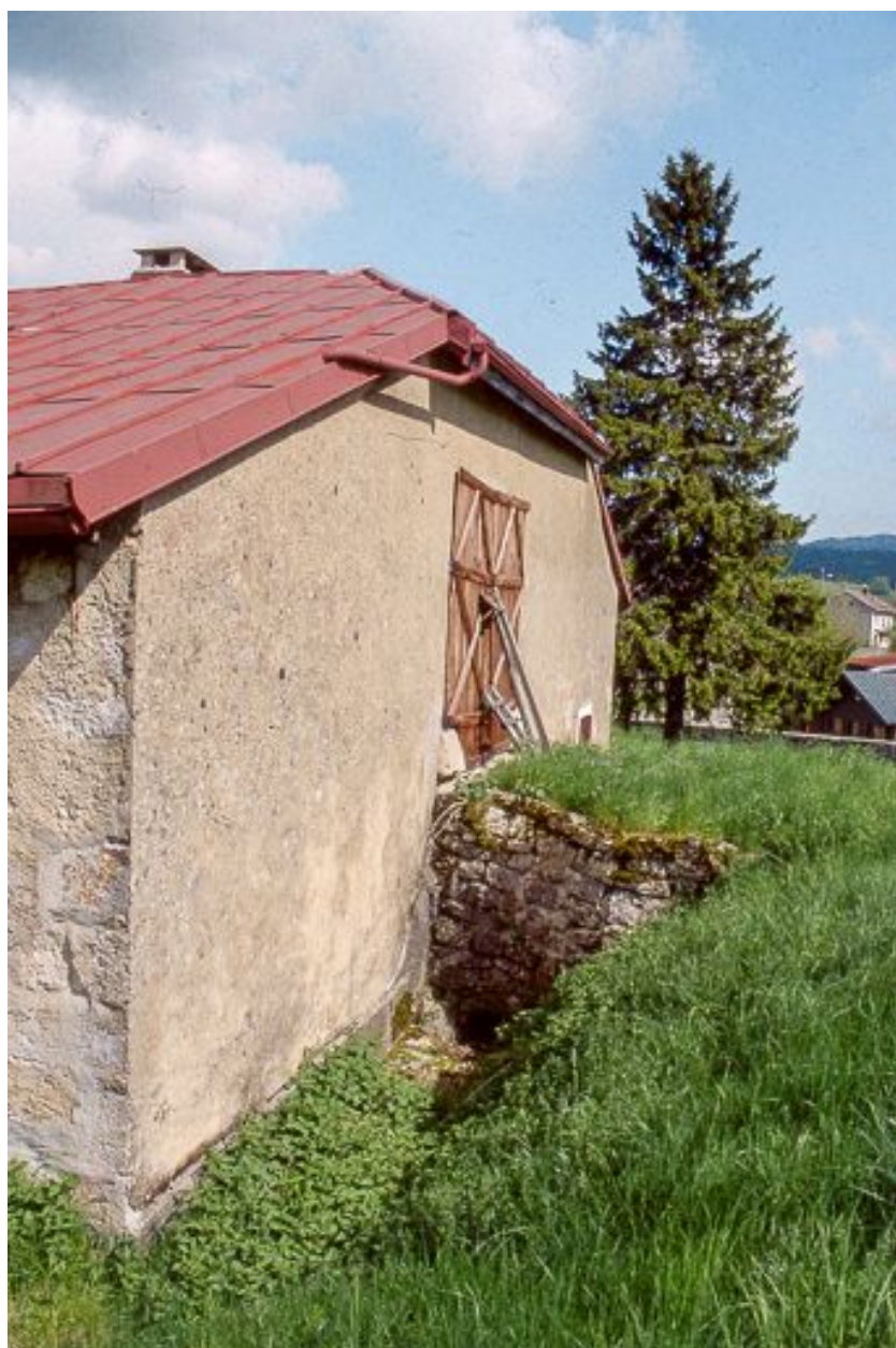
Face gauche et levée de grange.
