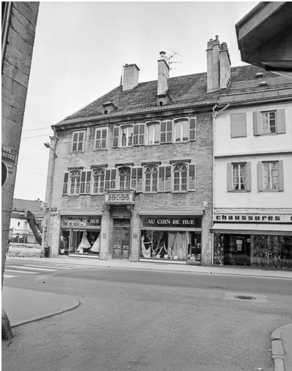
Façade sur rue, vue de trois quarts droit.
