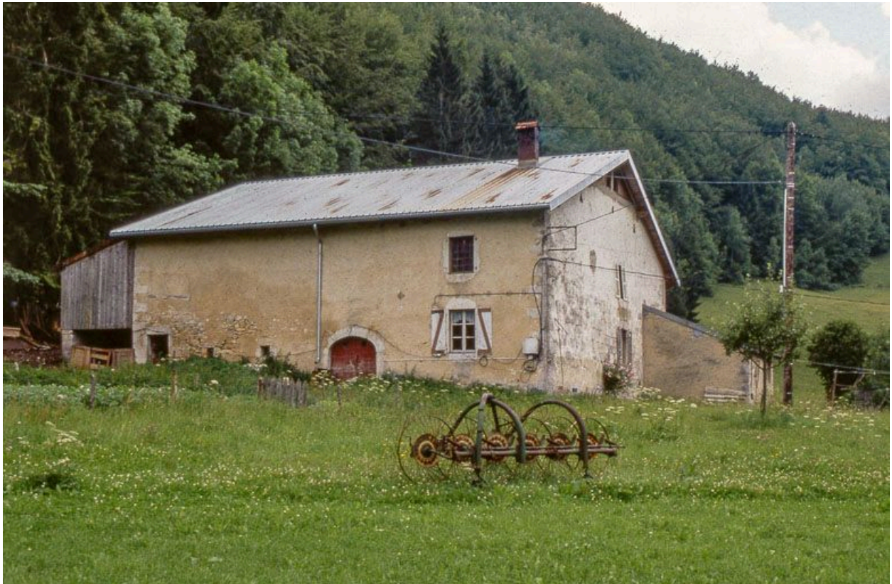
Vue éloignée de la façade postérieure.
