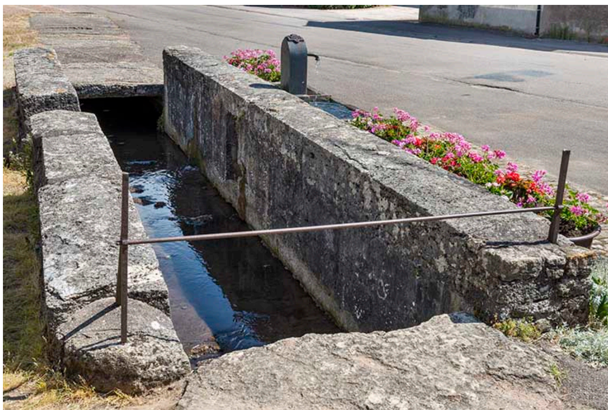
Le ruisseau canalisé alimentant les bornes fontaines.
