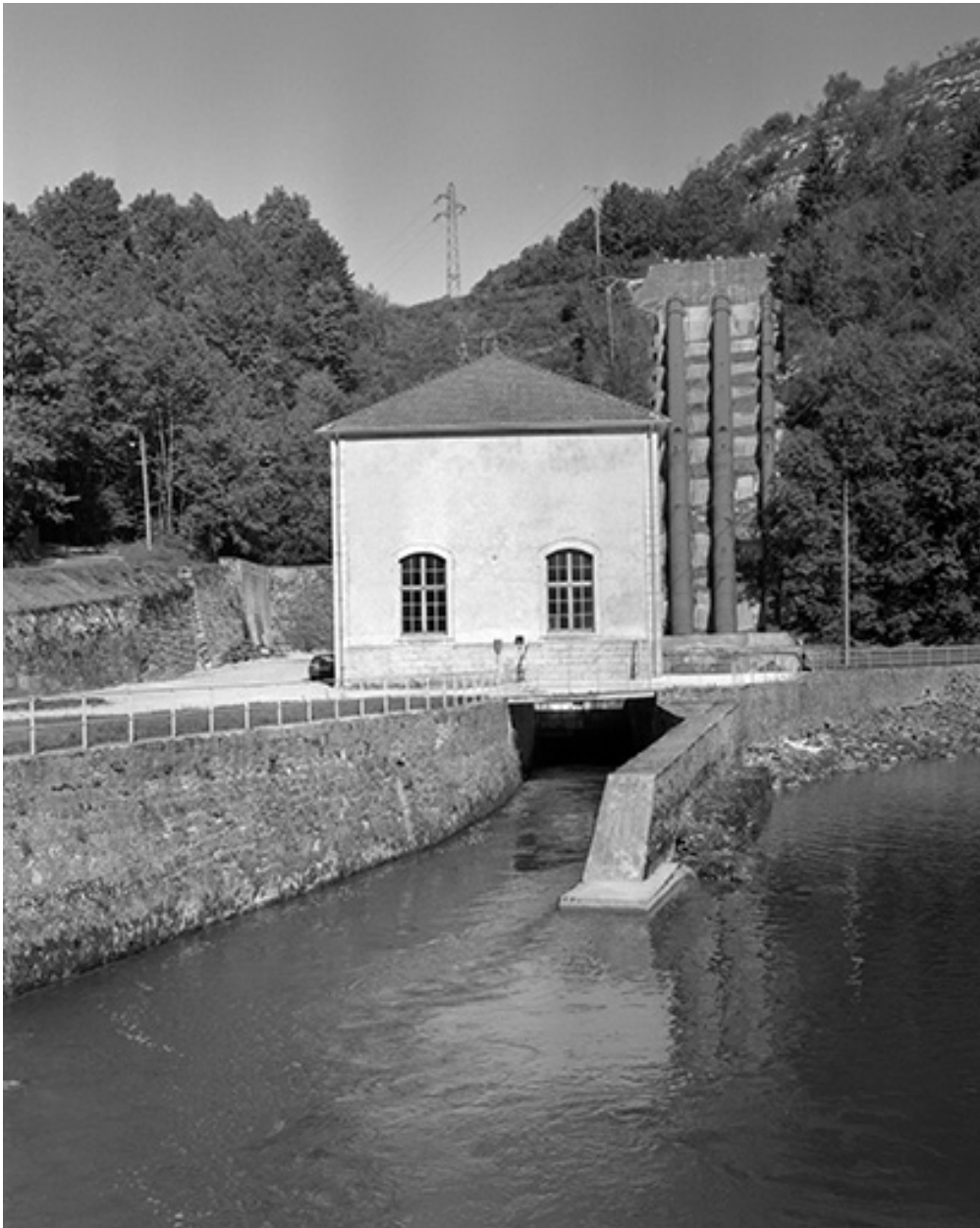
Façade latérale droite de la centrale et canal de fuite.
