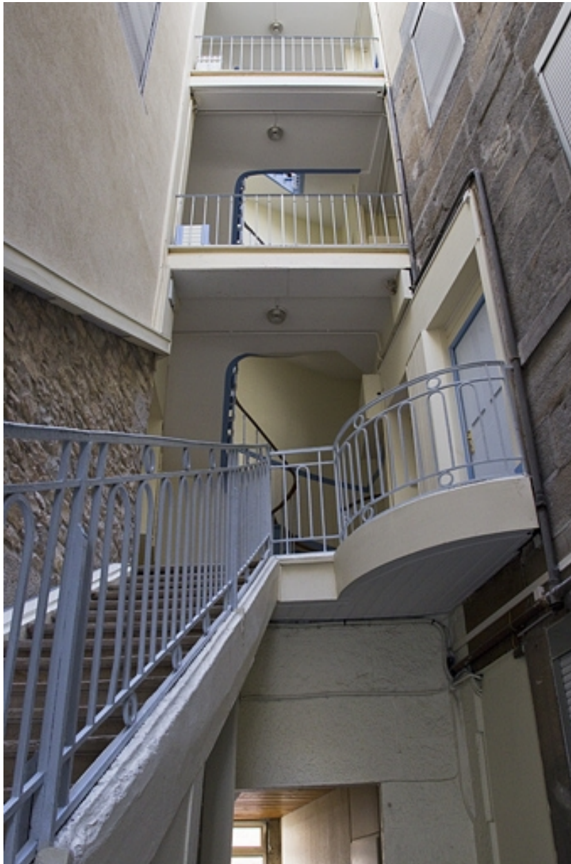
Logis principal, escalier : détail de la partie supérieure.
