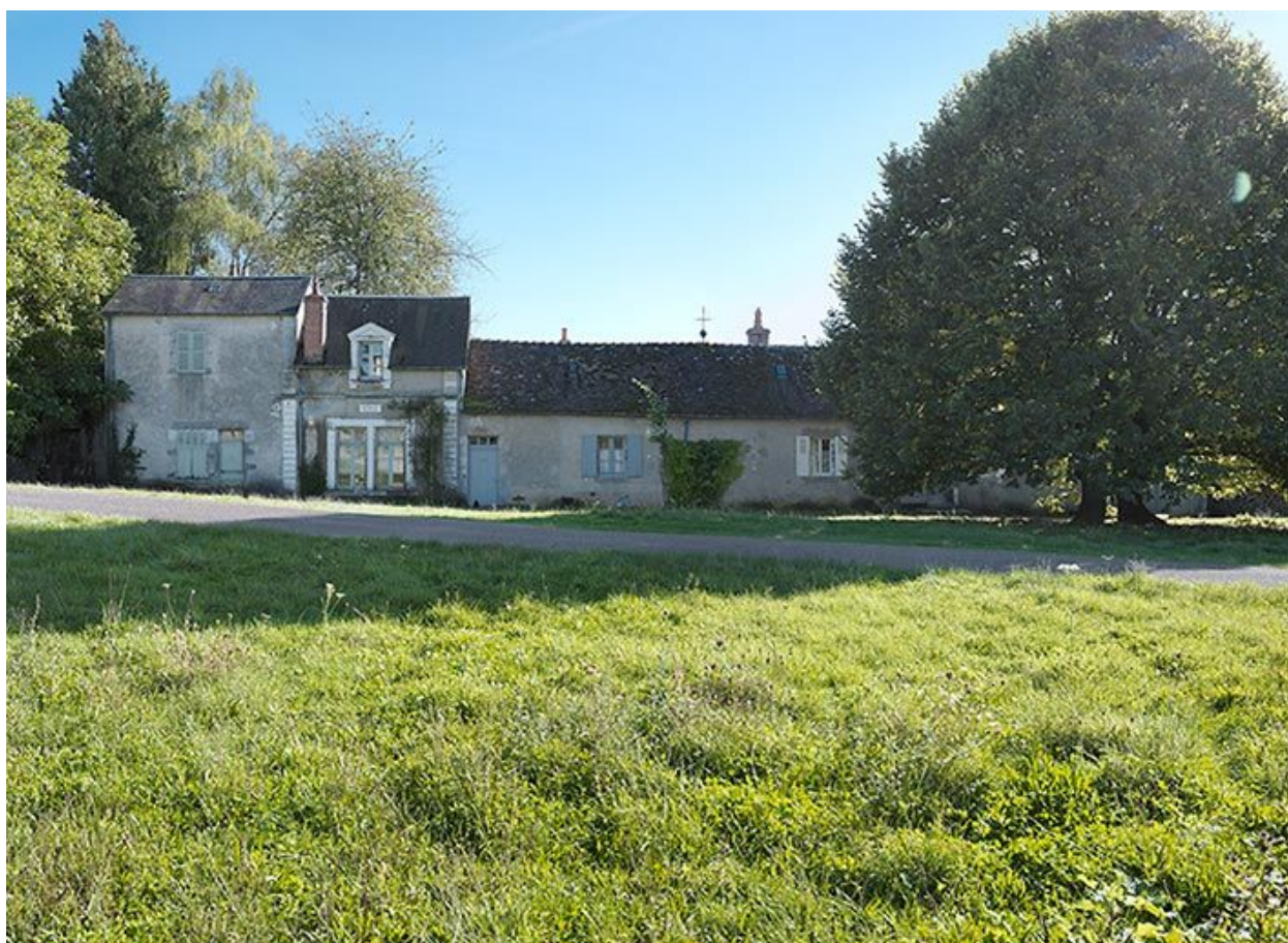
Vue d'ensemble des bâtiments, de face.
