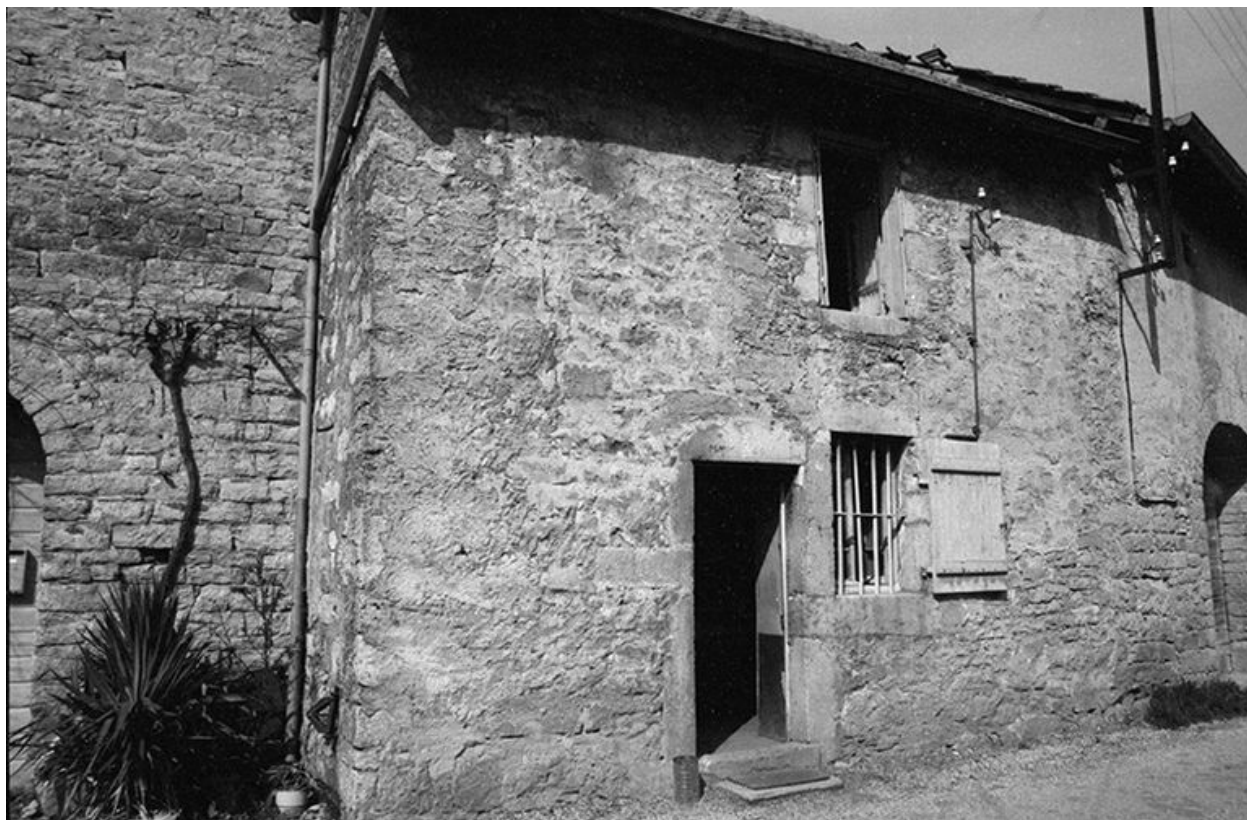
Ferme cadastrée 1964 AB 54 : partie habitation.
