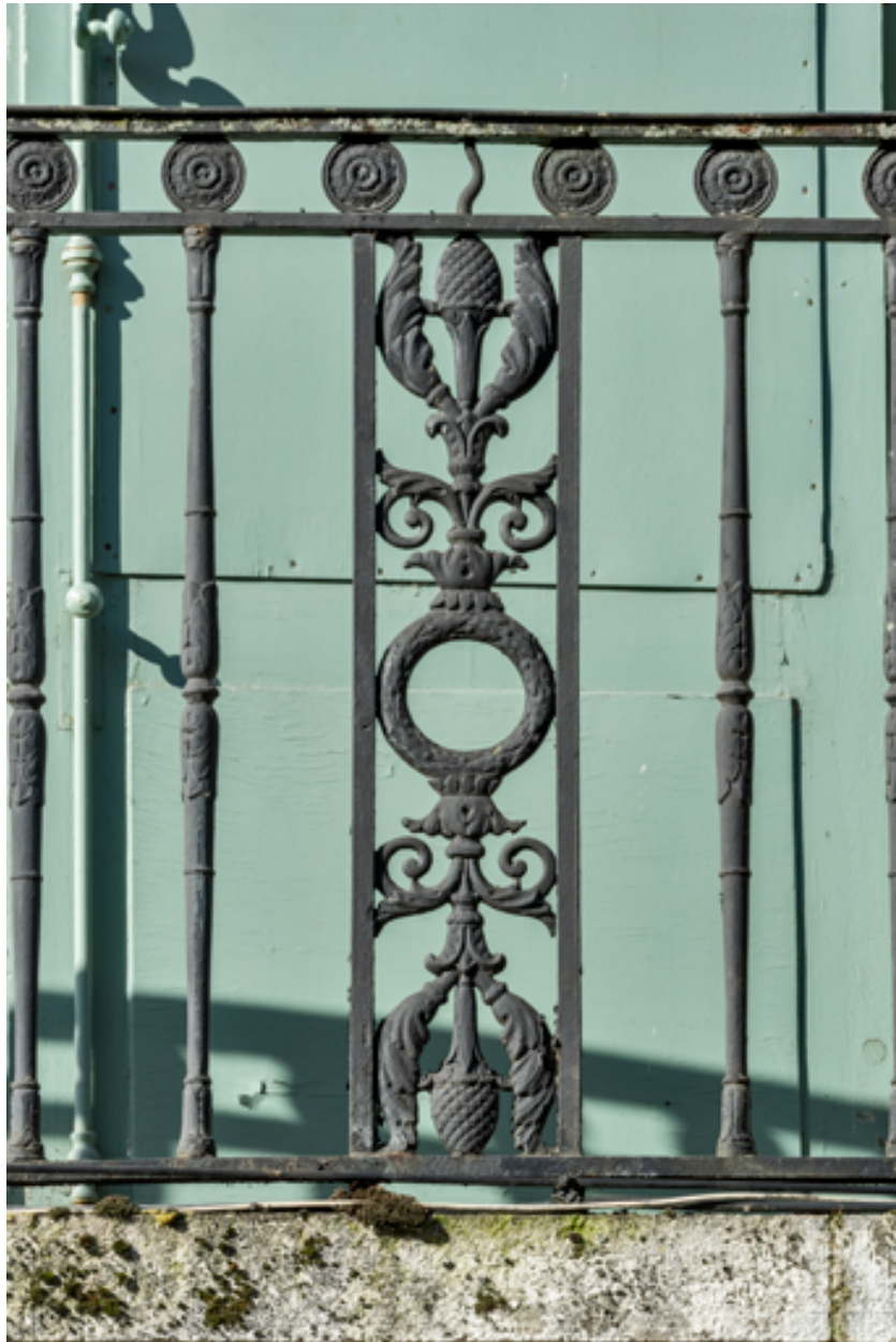
Façade antérieure, avant-corps central : détail du garde-corps en fonte du balcon.
