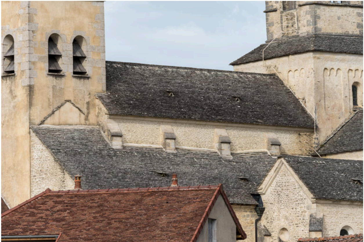
Vue d'ensemble côté nord.
