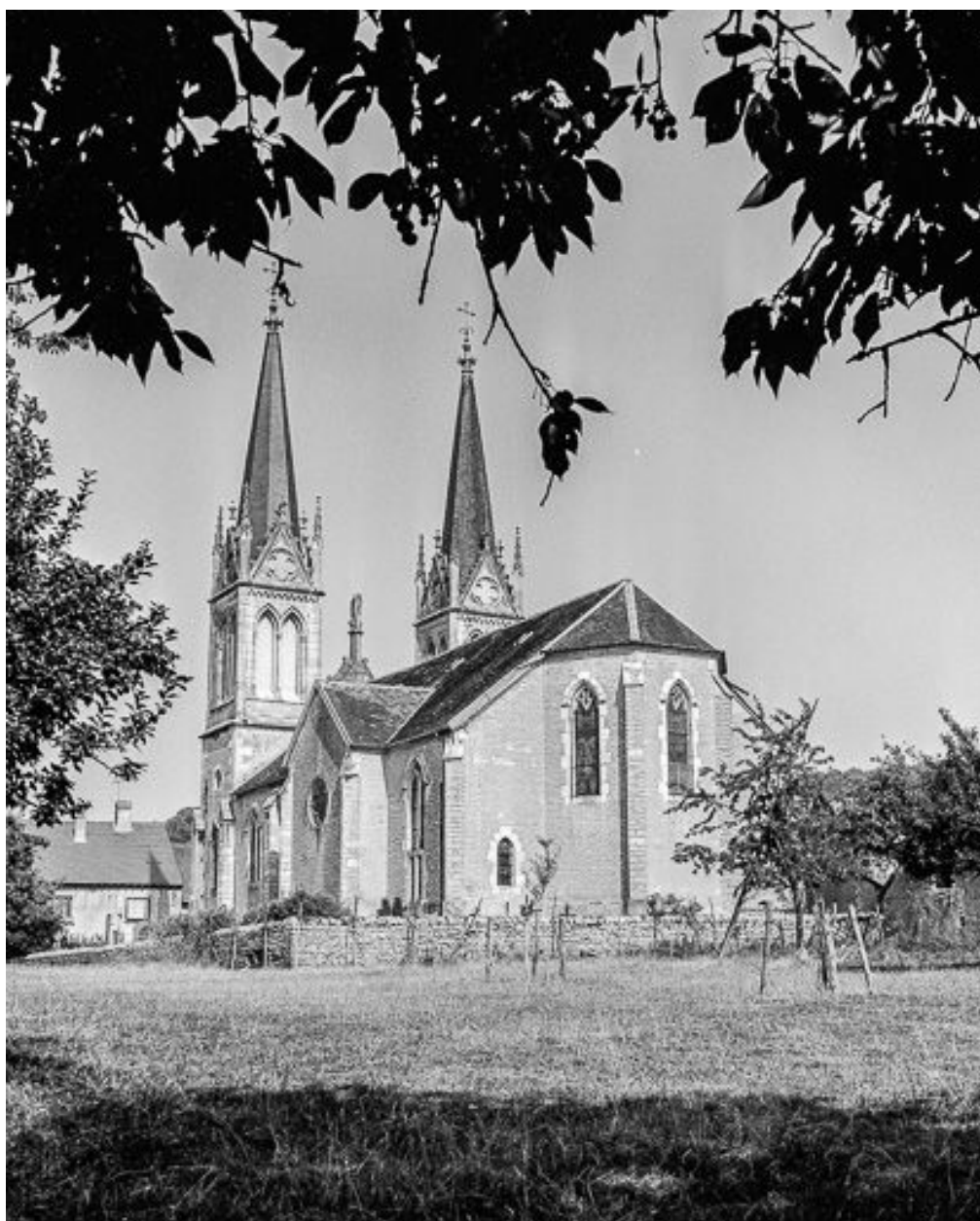
Extérieur : façades postérieure et latérale droite.
