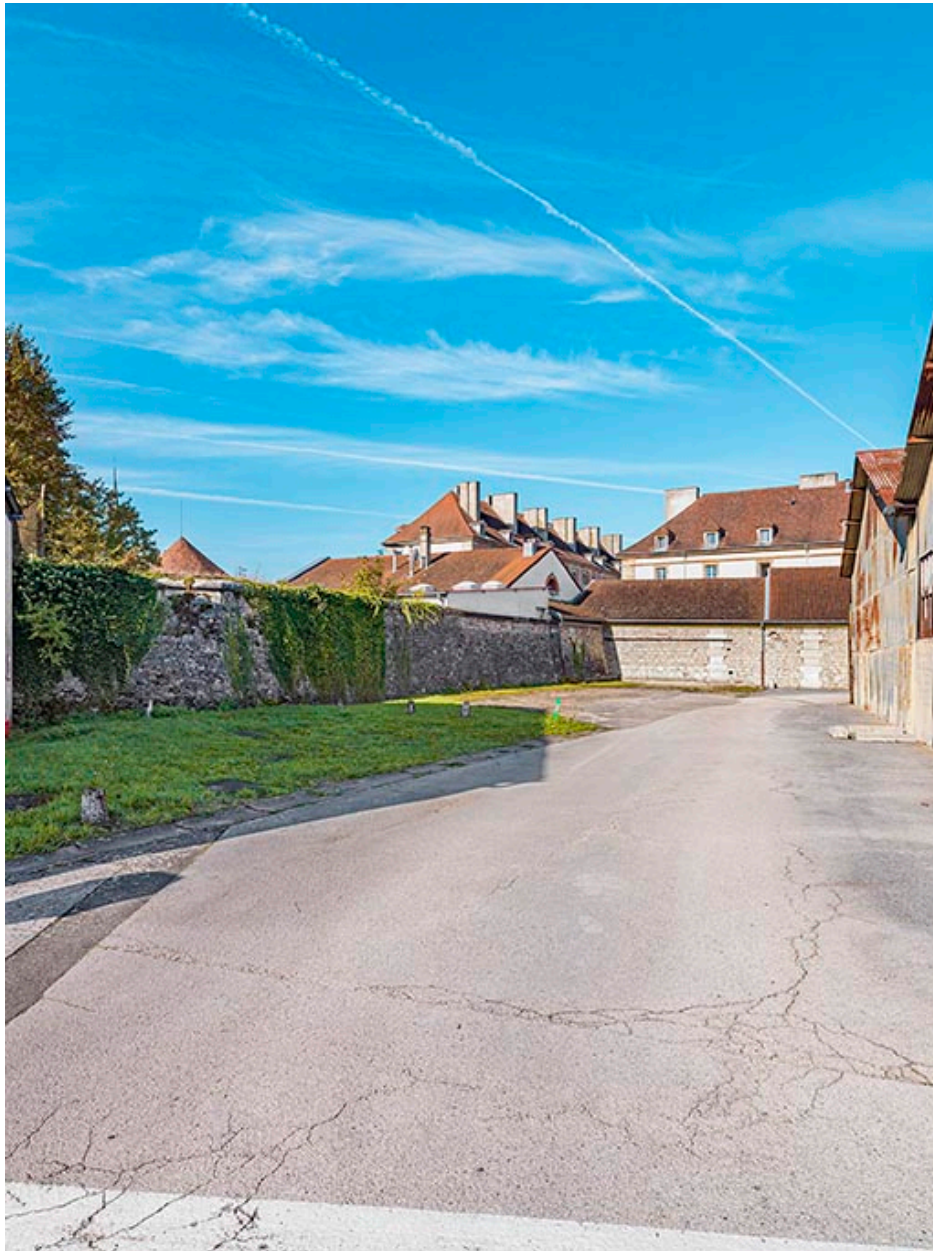
Flanc nord du bastion.
