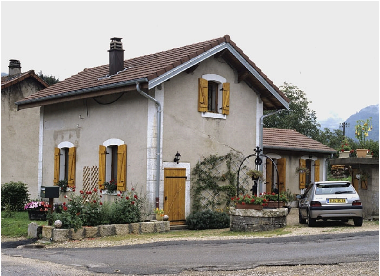
Façades nord et ouest.
