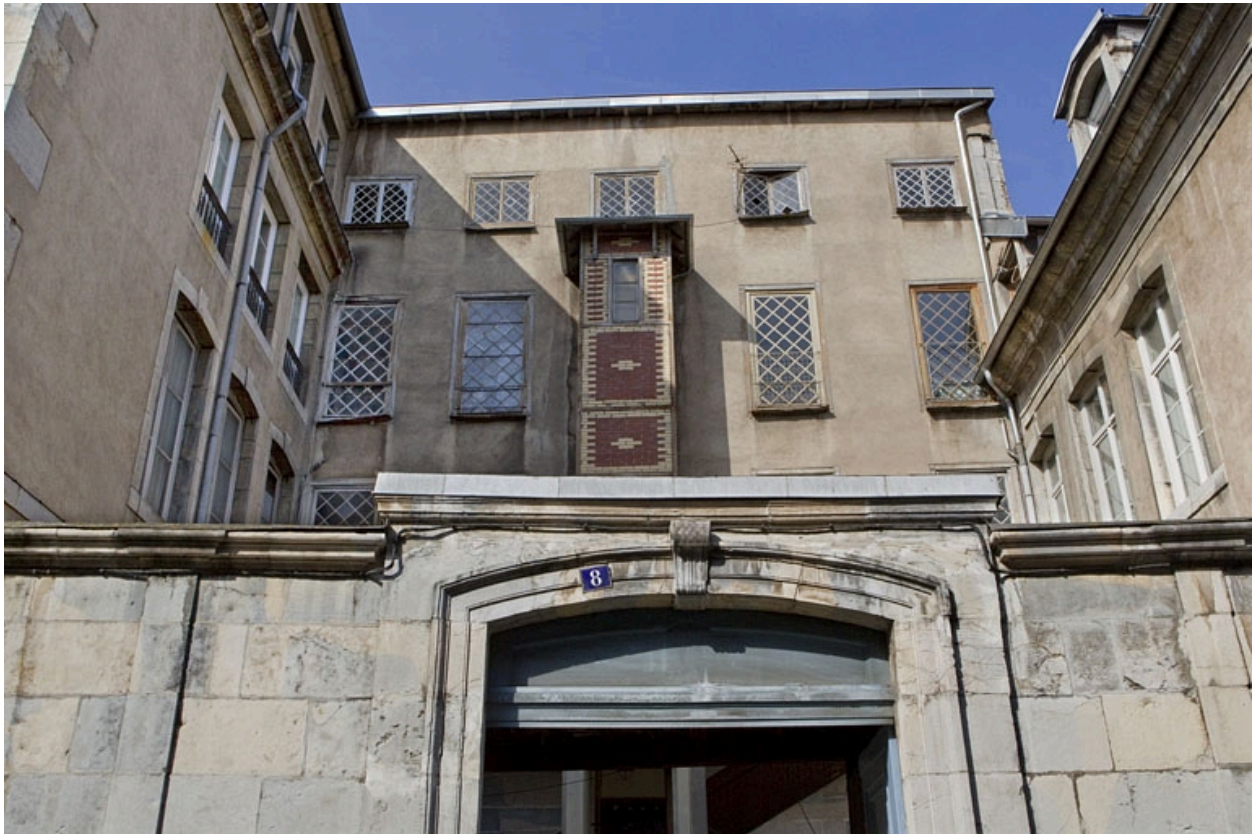
Vue d'ensemble de la clôture sur rue et de l'aile de l'escalier en fond de cour.
