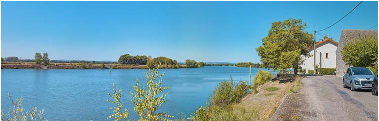
Rampe amont du port d'Ouroux.
