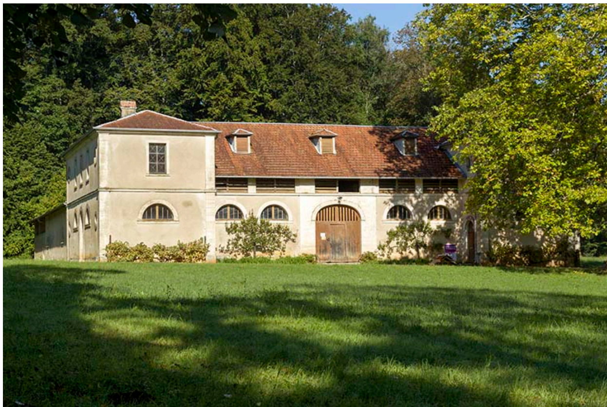
Vue générale de la façade sud-est.
