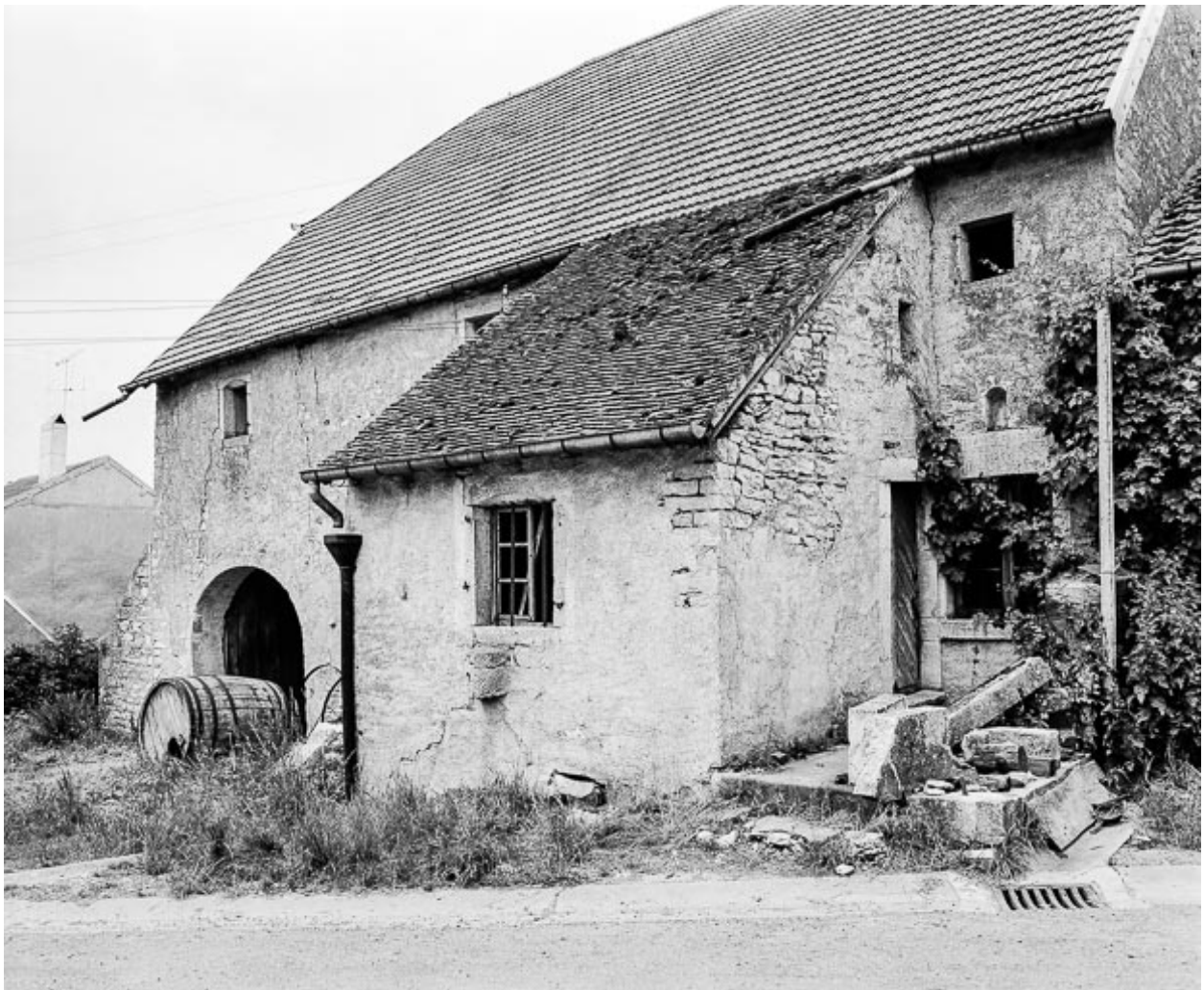
Détail : entrée d'habitation.
