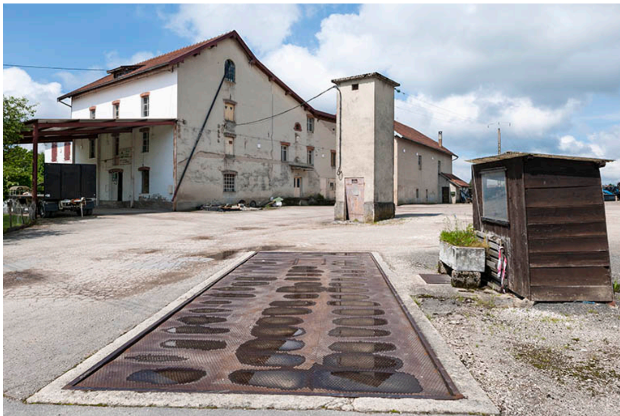
Vue d'ensemble depuis le pont bascule.
