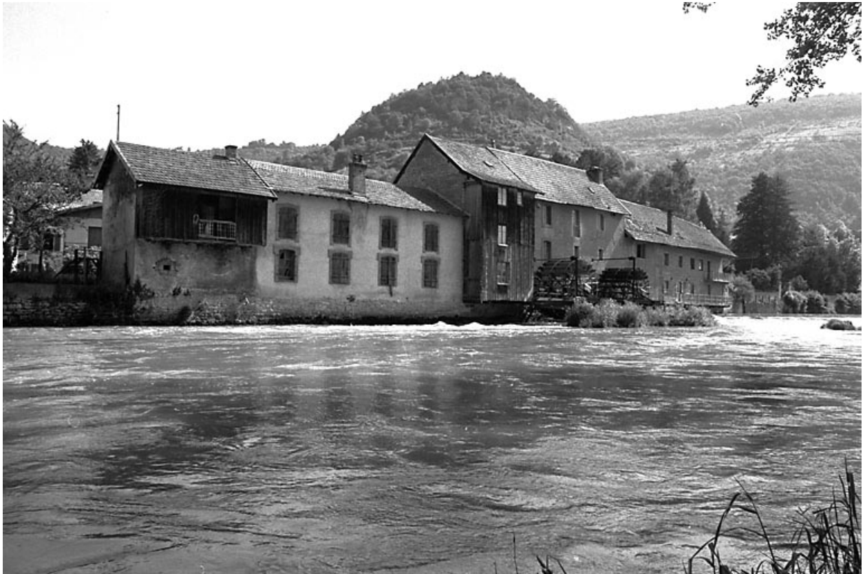
Moulin situé route de Pontarlier.
