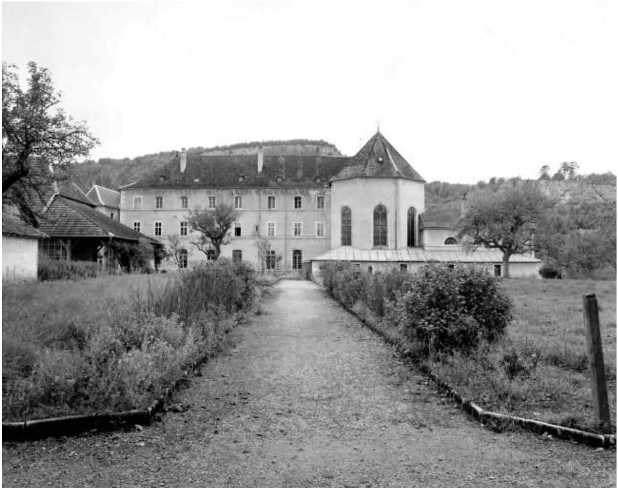
Vue générale depuis le nord.
