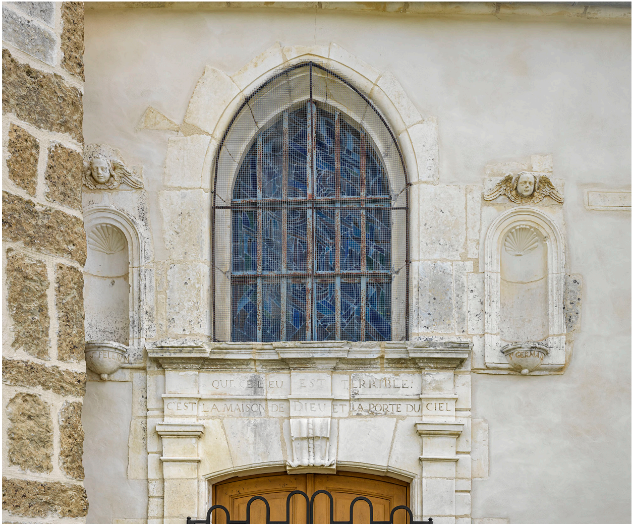
Élévation nord : détail du portail et de la baie éclairant le transept.
