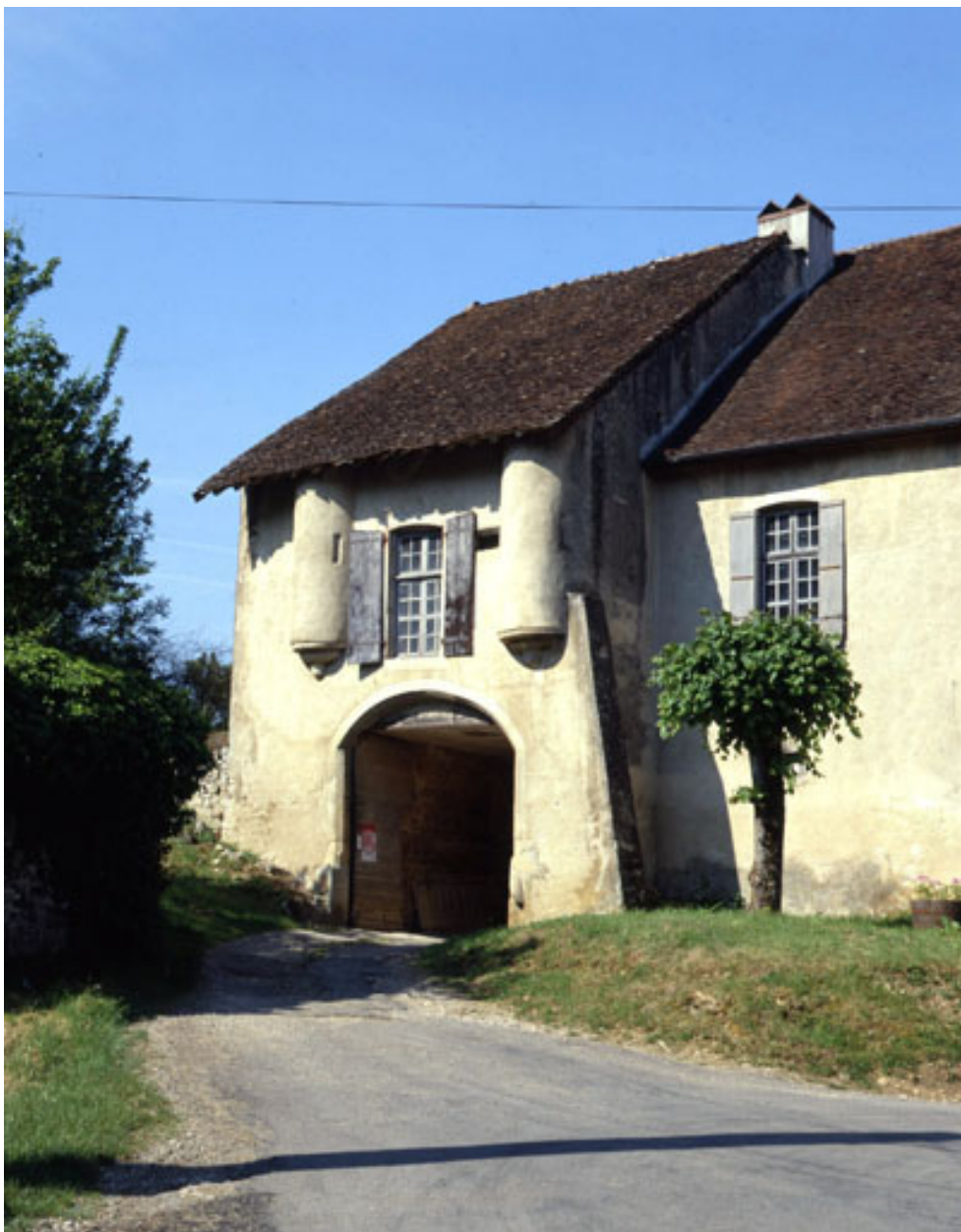
Bâtiment d'entrée : porche et façade latérale gauche.
