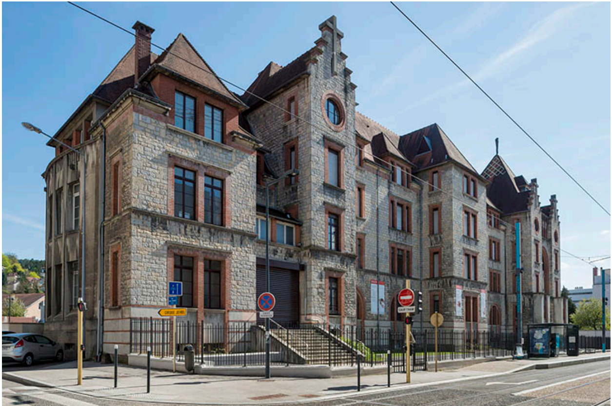
Façade antérieure du lycée. Vue de trois quarts gauche.
