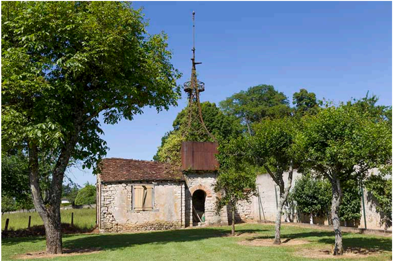
Bâtiment avec éolienne en fond de parcelle.
