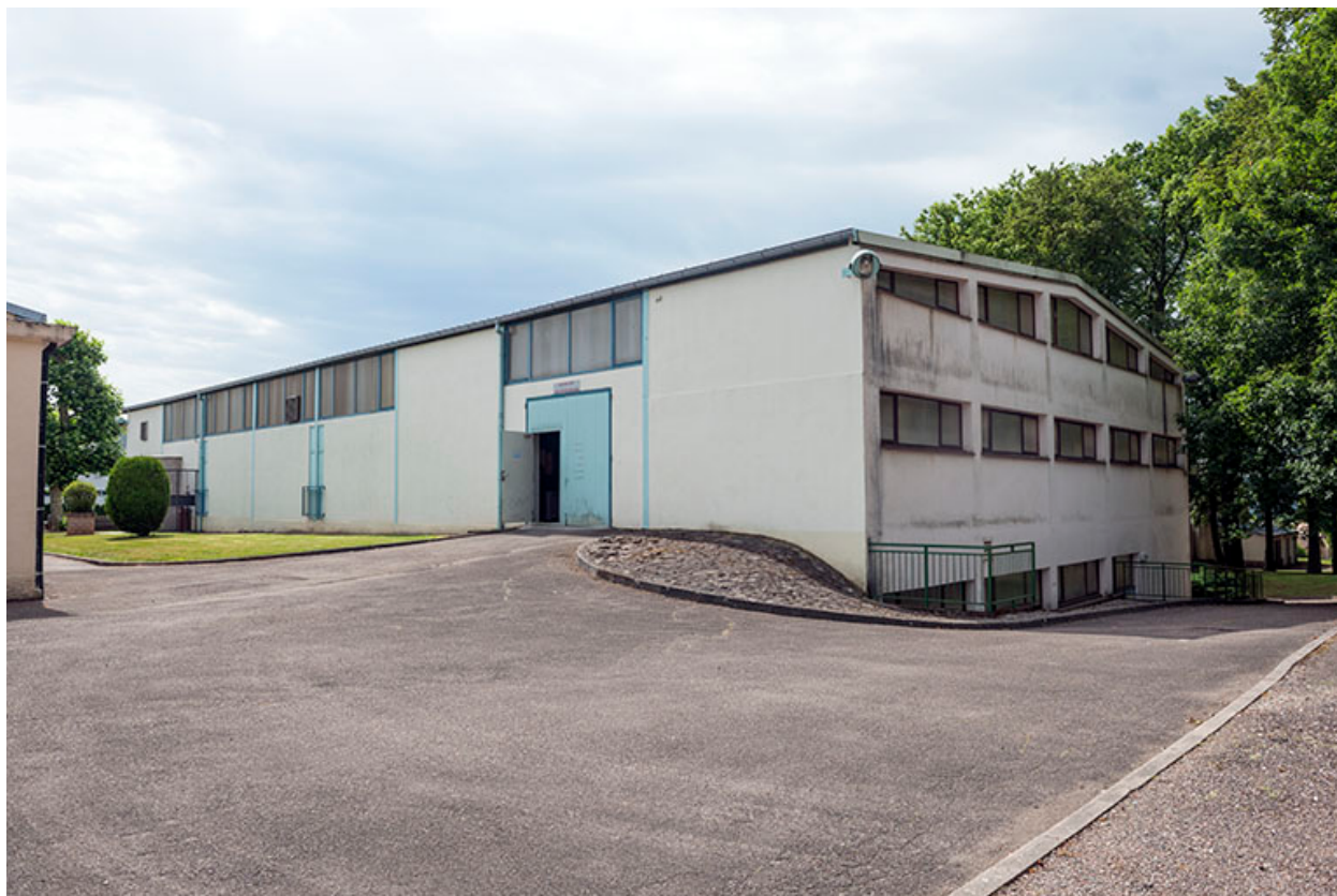
Atelier de gros-oeuvre : façade antérieure.
