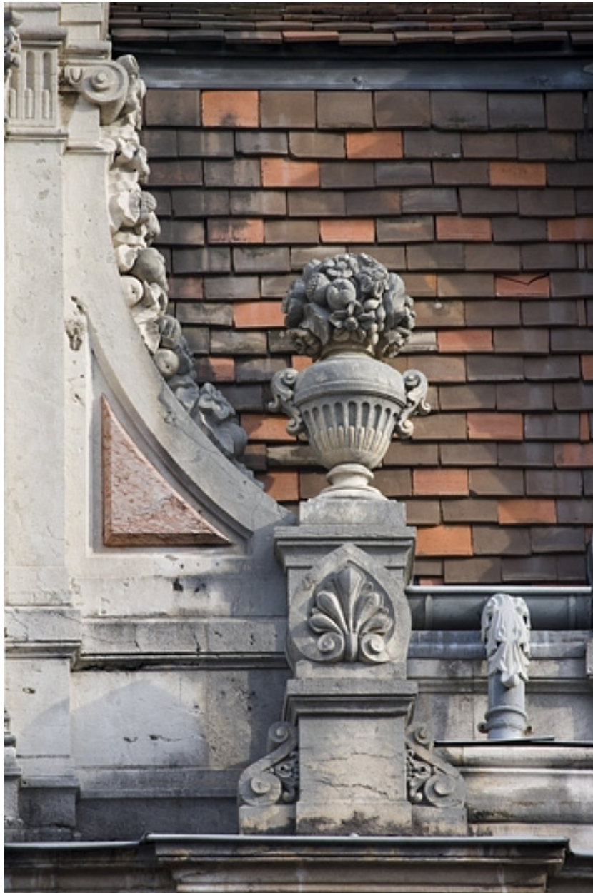
Détail de l'aileron droit d'une lucarne.
