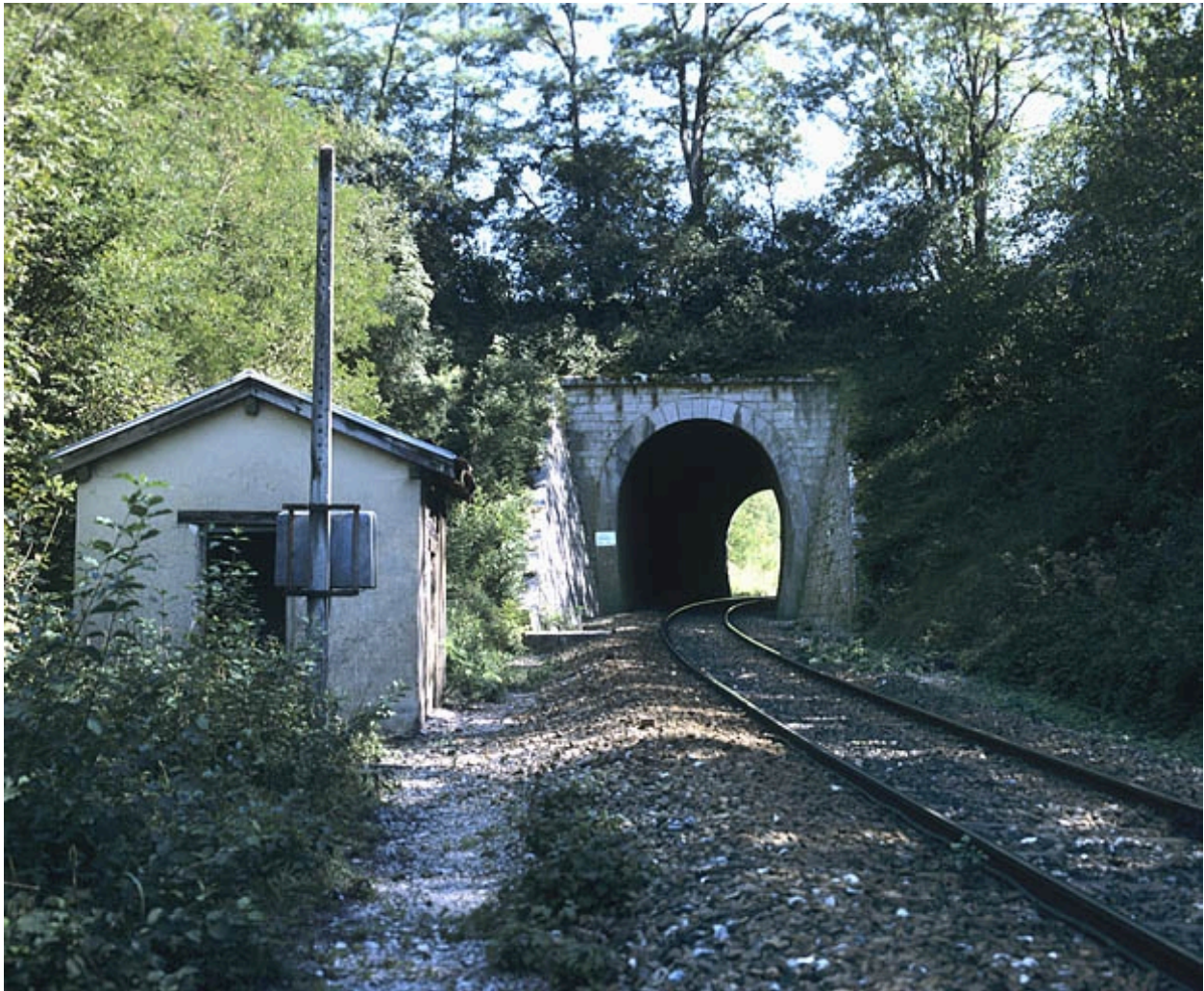
Tunnel d'Arbent 2 : tête côté Andelot-en-Montagne (ouest).
