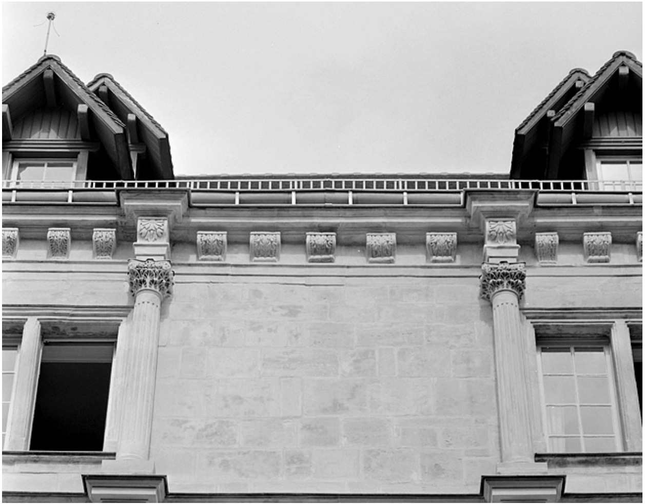
Façade sur la place, troisième étage, détail de l'ordre composite de la travée centrale.
