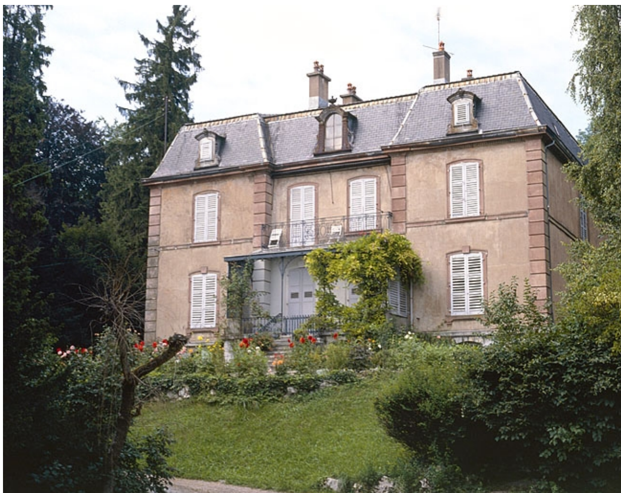
Façade sud du corps de bâtiment principal.
