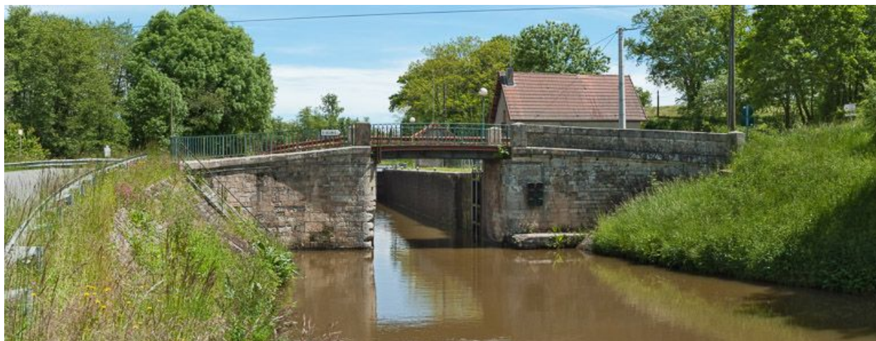
Le pont, vu d'aval.
