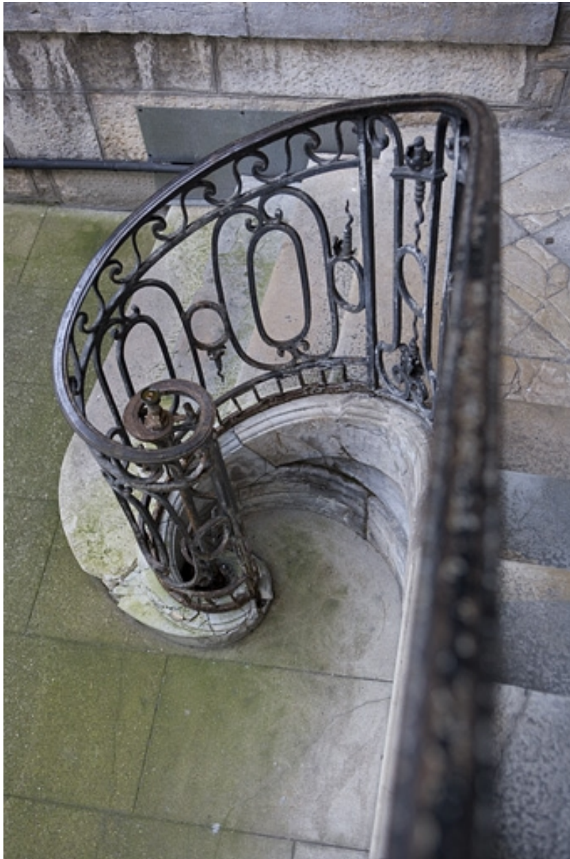
Détail du départ de la rampe en fer forgé de l'escalier à cage ouverte.
