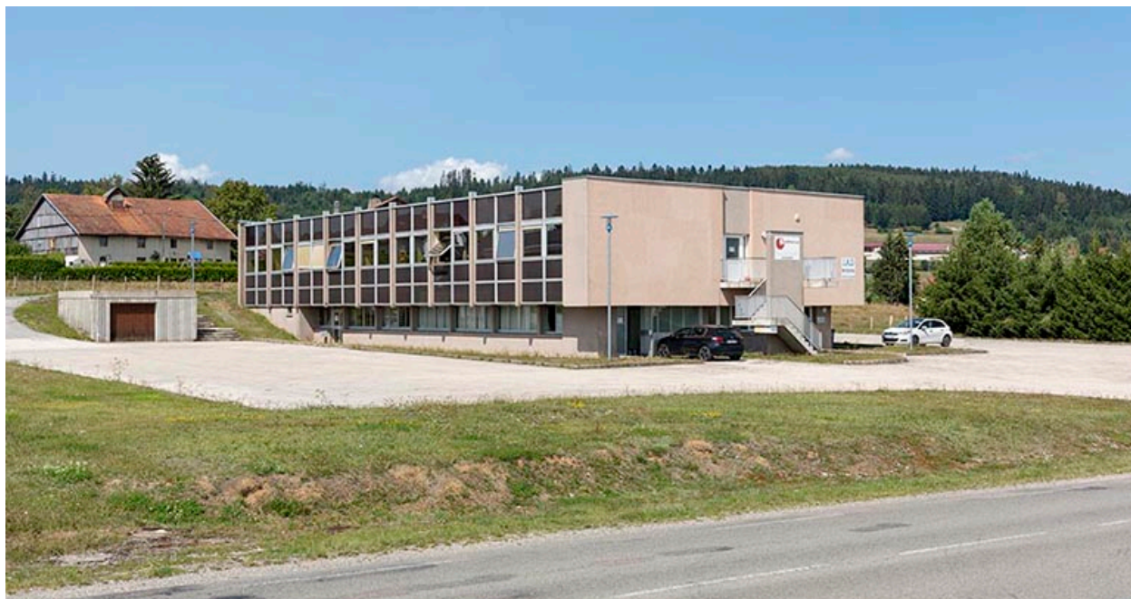
Façades antérieure et latérale droite.
