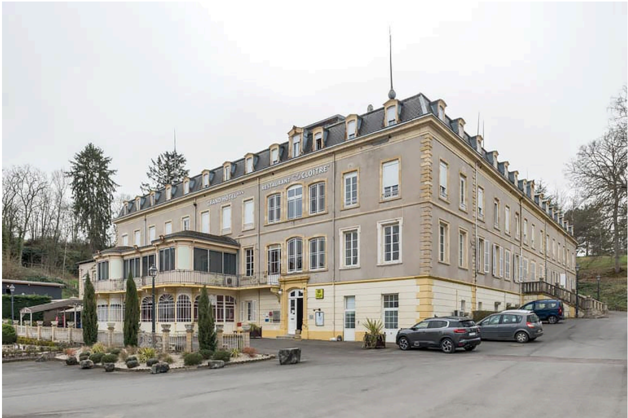
Aile ouest, vue d'ensemble.
