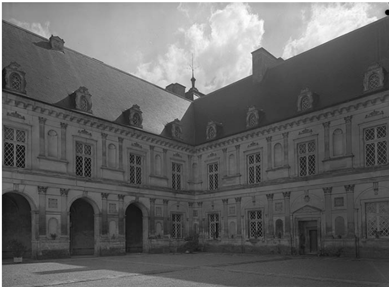
Façades sur cour (nord et est).
