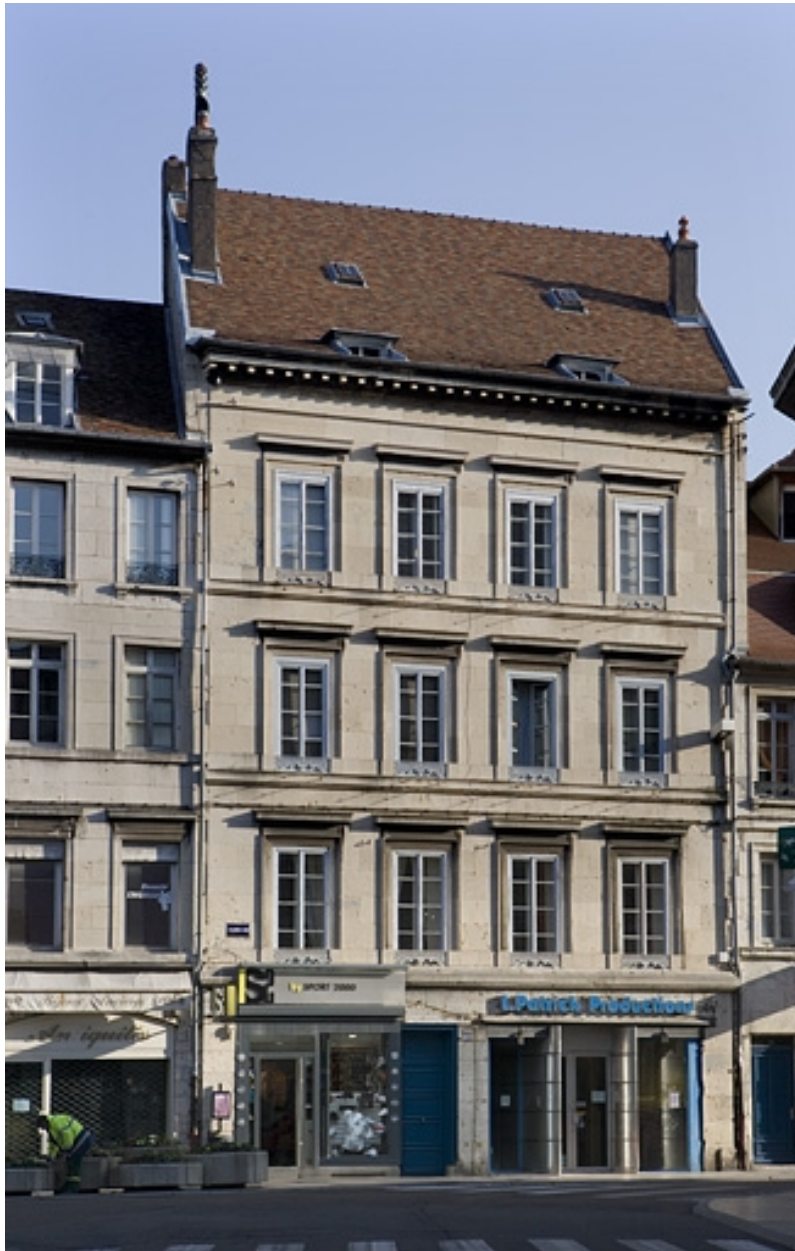
Vue d'ensemble de la façade sur rue.
