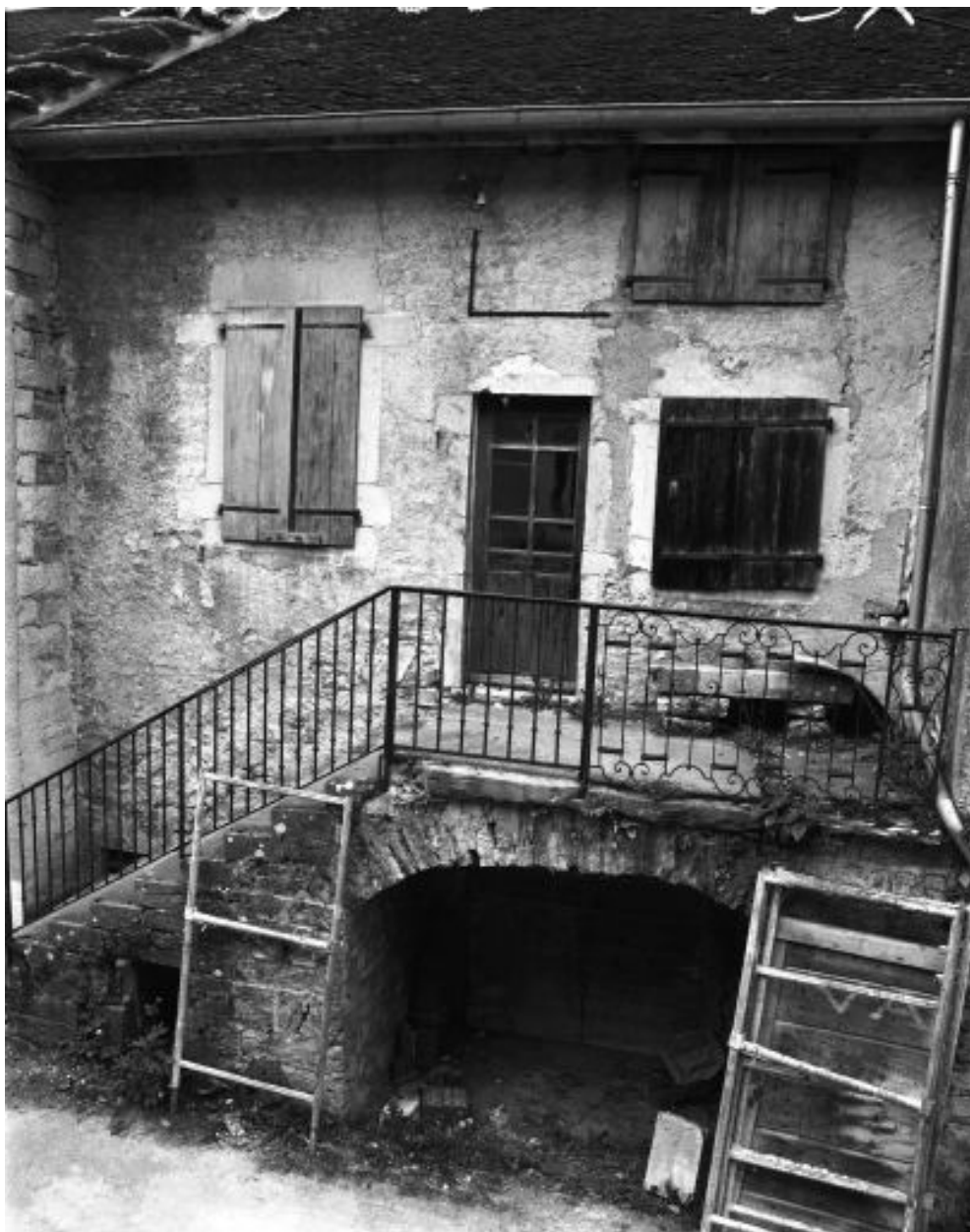
Façade antérieure vue de face en 1981.
