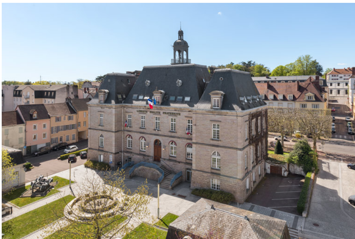
Vue d'ensemble plongeante, depuis le nord-est.
