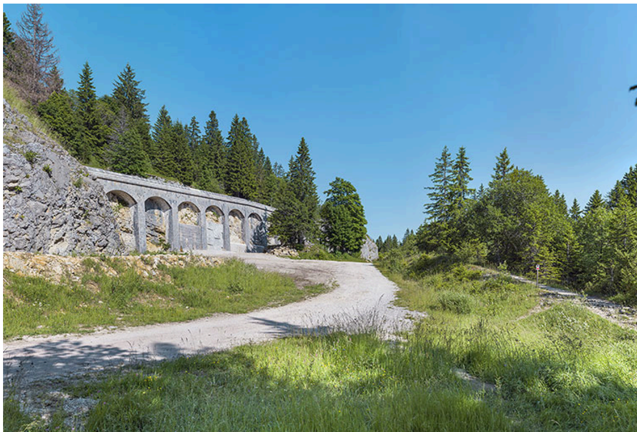
Front sud-ouest : l'enceinte close par le rempart avec ses arcs de décharge.
