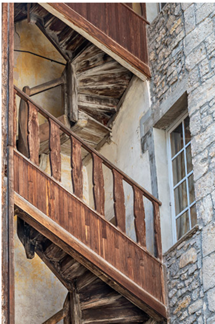
Première cour. Escalier hors-oeuvre.
