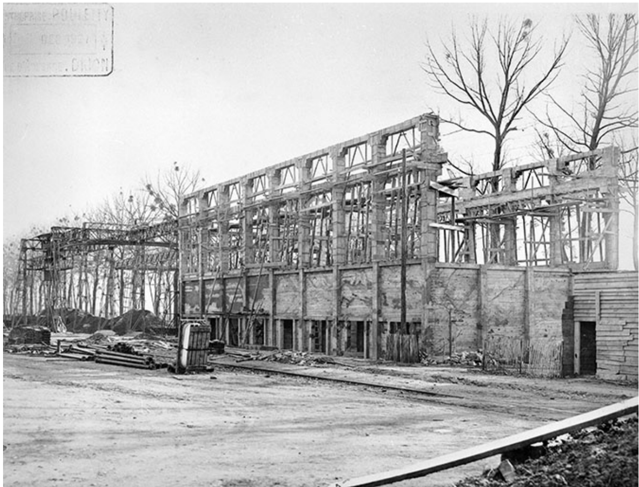
Hangar à terre (18) en construction.
