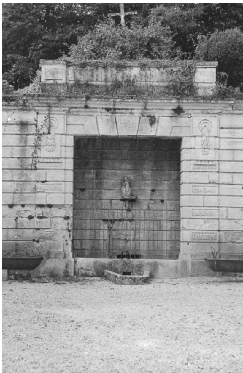
Vue de la partie centrale.
